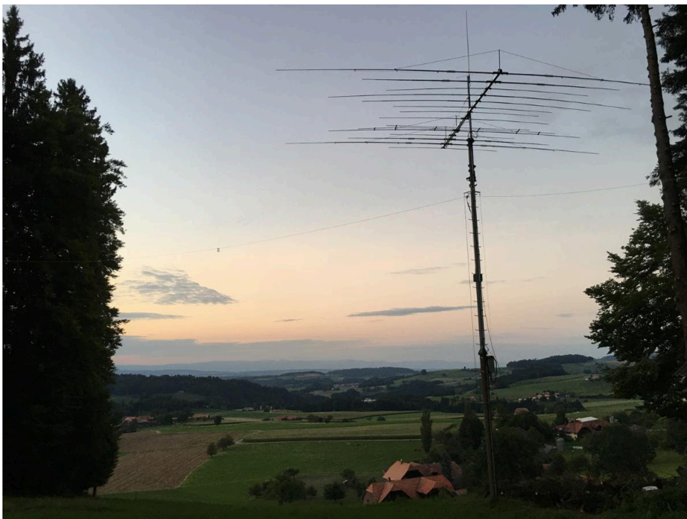
Teile der Infrastruktur der Remotestation HB9EH0/HB9FXQ:
